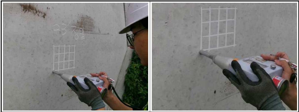
【그림 13.3.6】 슈미트해머를 이용한 반발경도시험 전경
